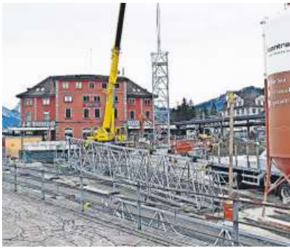
Der geplante Kran musste wieder abgebaut werden. Bild: Werner Geiger
